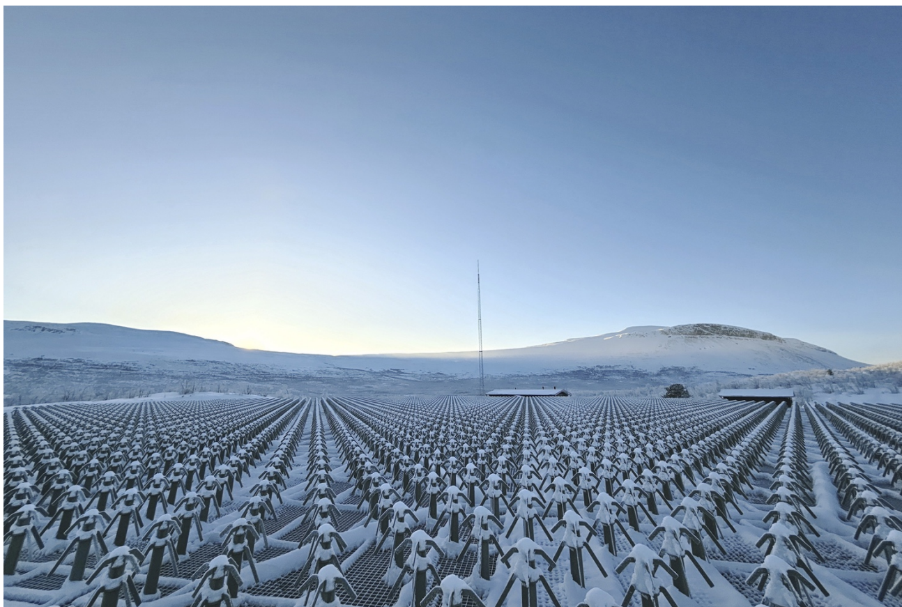
Dipolantenner vid EISCAT_3D-anläggningen i Kaiseniemi, Sverige. Foto: Johan Svensson / EISCAT AB
