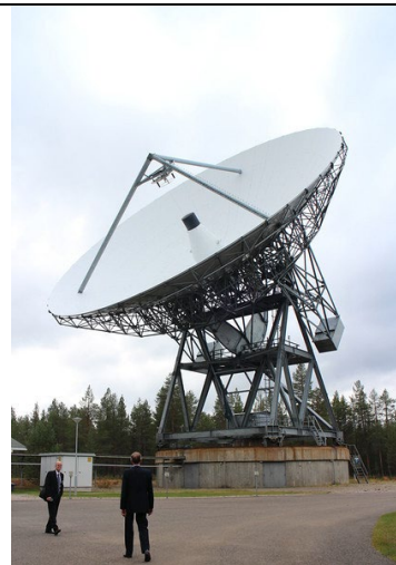
The EISCAT Sodankylä site antenna Location: 67°21'49"N 26°37'37"E EISCAT Sodankylä Tähteläntie 54D FIN-996 00 Sodankylä Finland
